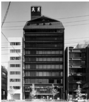
1928年から続いた土蔵造りの旧社屋(上)から、近代的な地上11階建ての新社屋(下)に。
